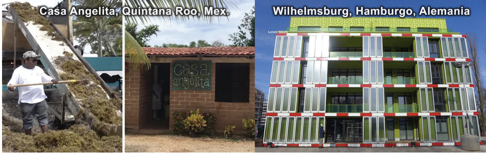
FIGURA 3. CASA Angelita, construida con bloques de sargazo (Foto: SIPSE). La casa de las algas en Alemania (Foto: Googlemaps) con paneles de biorreactores de algas para calefacción y producción de energía.
