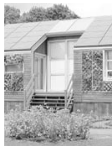
Figura 2. La incorporación de calentadores solares y sistemas fotovoltaicos en edificaciones ya son una realidad que armoniza la generación de energía y los elementos estéticos, como se muestra en esta fotografía.
