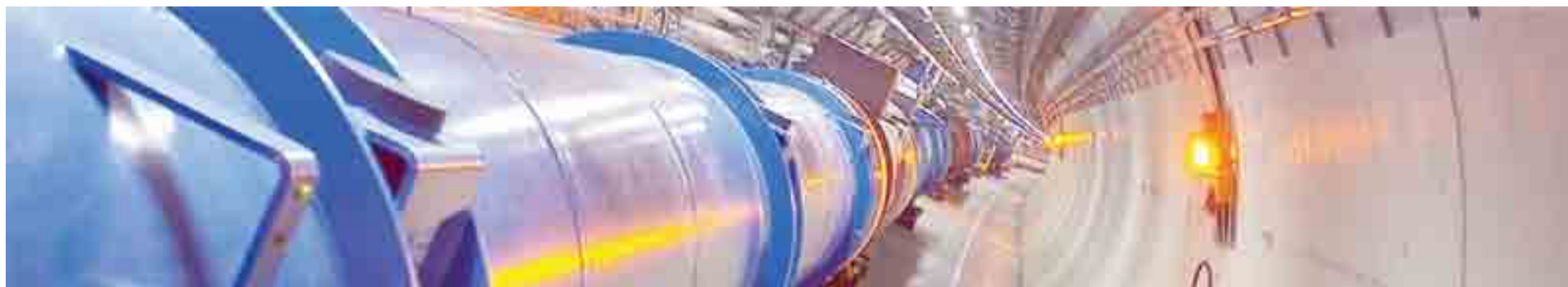
Figura 2. Vista interior del anillo de almacenamiento del sincrotrón de Daresbury.
