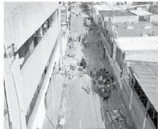
b) Daños observados en una calle en Joutitla
