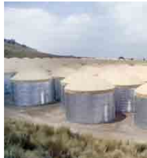
1. Observatorio HAWC constituido por trescientos tanques llenos con doscientas toneladas de agua c/u y con cuatro fotomultiplicadores colocados en su interior.
