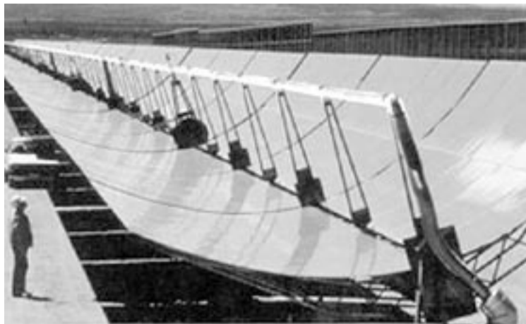
Figura 1. Concentrador de canal parabólico de las plantas SEGS, en Kramers Junction, California.
