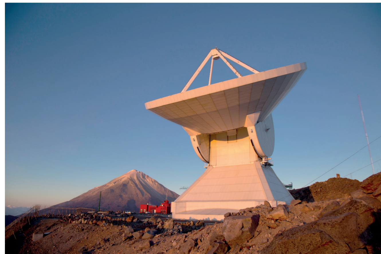
FIGURA 2. EL GTM trabaja a toda su capacidad, con un reflector primario de 50 metros de diámetro, a partir de 2018.
